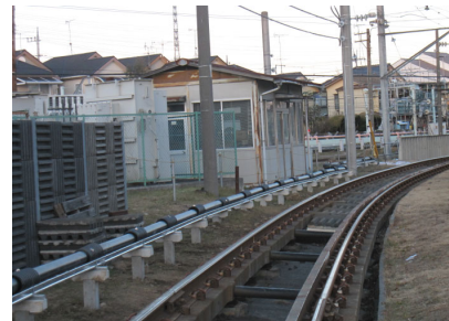
鉄道用超電導ケーブル（310 m長）
