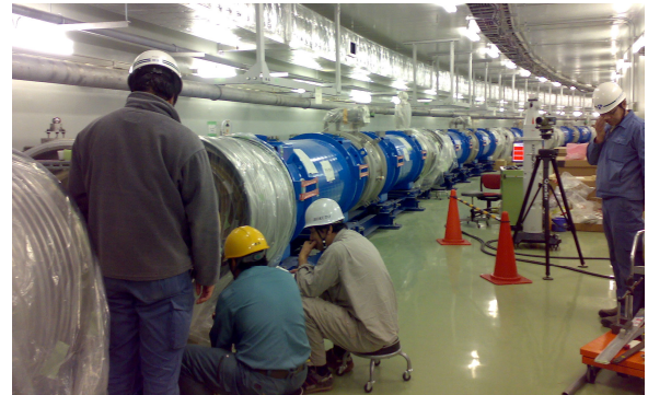
図2. トンネル内設置作業
