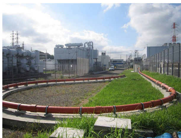
図4 旭変電所超電導ケーブル (Uターン部)
