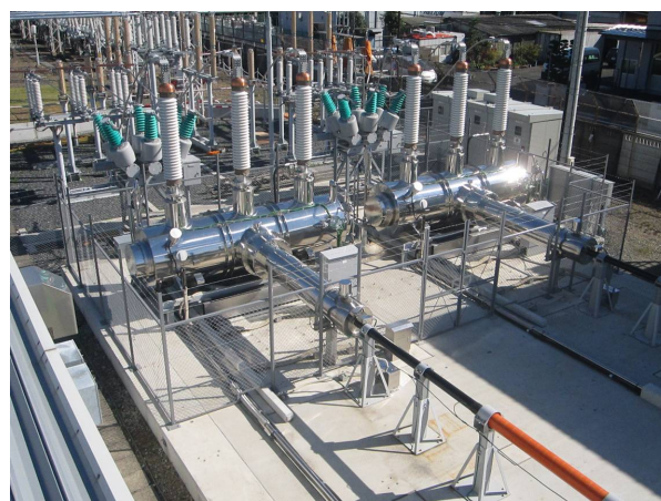
図5 旭変電所超電導ケーブル (端末部)
