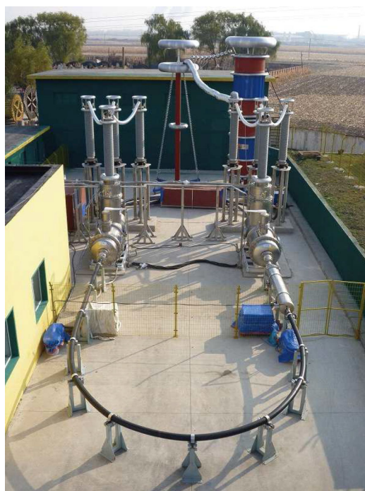
図12 275 kV-3 kA 超電導ケーブル (中国瀋陽市)
