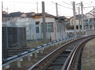
鉄道用超電導ケーブル (310 m 長)
