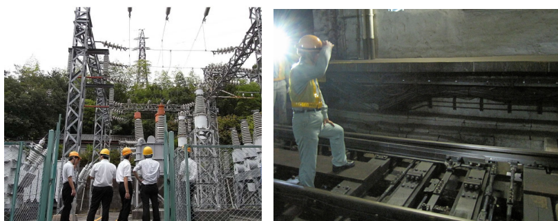
超電導技術の導入のための現地調査
